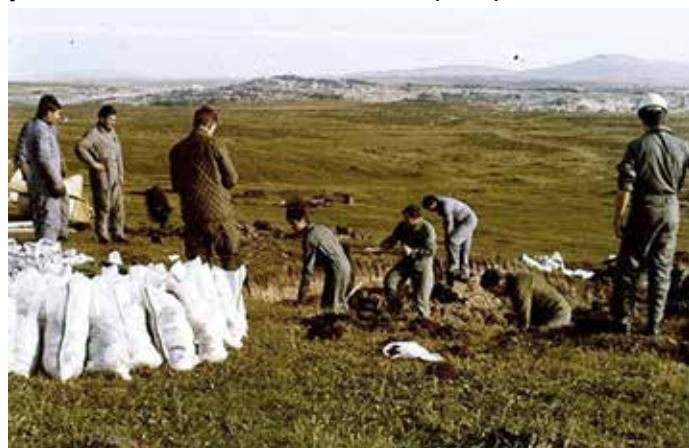
Construyendo los refugios
