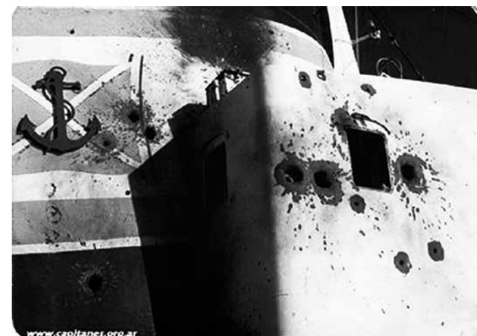
Impactos en el Río Carcarañá en su superestructura
