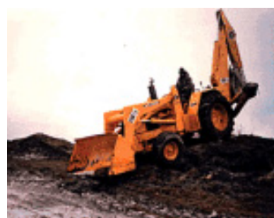
Maquinas viales en operación
