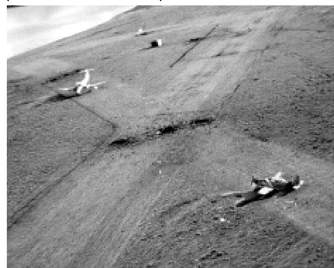
Fotografía que muestra los daños en la pista de la Isla Borbón
