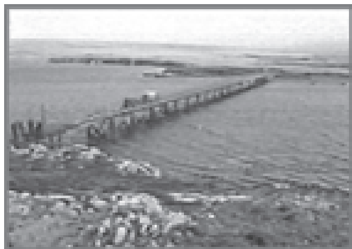
Vista general del puente
