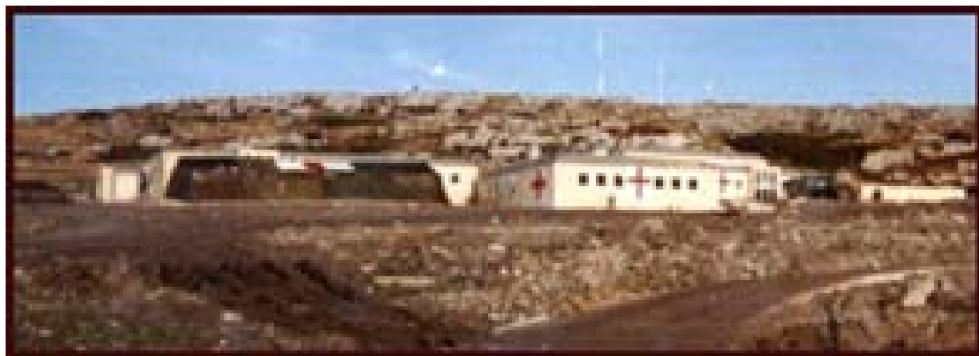
Vista panorámica del Hospital Militar Conjunto
