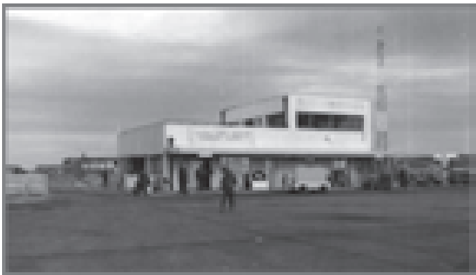
Aeropuerto de Puerto Argentino en 1982
